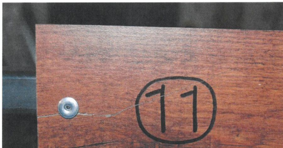
Obr. č. 8: Poškození vzorku - vzorek č. 11
