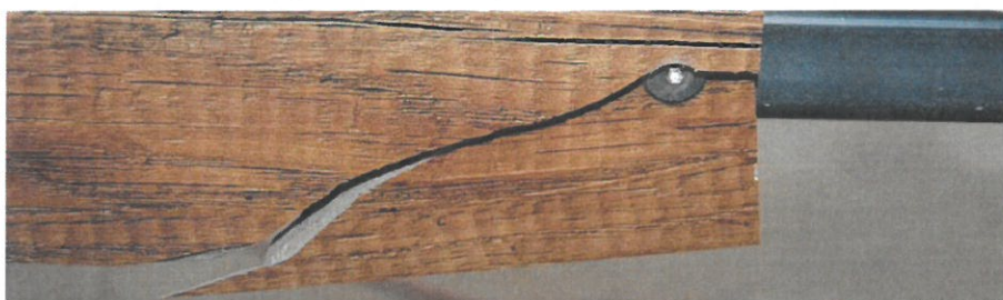
Obr. č. 6: Poškození vzorku - vzorek č. 6
