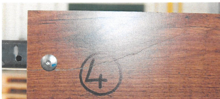
Obr. č. 4: Poškození vzorku - vzorek č. 4
